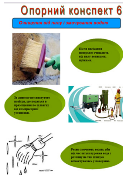
Рис.5. Опорні конспекти до уроку за темою: «Підготовка бетонної поверхні під обштукатурювання вручну та із застосуванням ручних механізованих інструментів»
